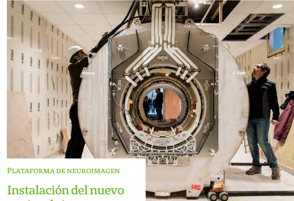
Instal·lació de la nova màquina de ressonància magnètica a les noves instal·lacions de la Fundació.
